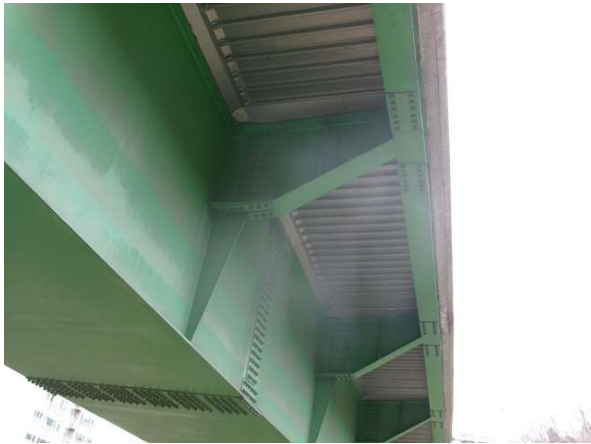
바닥판 하면 및 거더 전경
