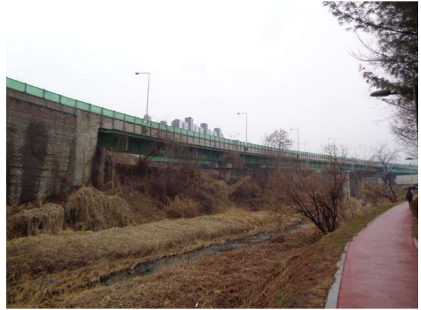
교량 측면 전경
